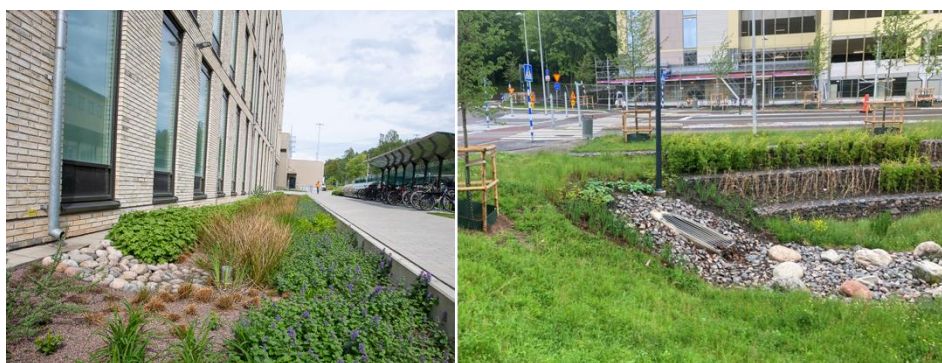
Figur 22. Exempel på nedsänkta regnbäddar. Alelyckan till vänster (fotograf: Lo Birgersson) och inlopp till Litteraturgatans regnbädd till höger (fotograf: Lina Engvall).
